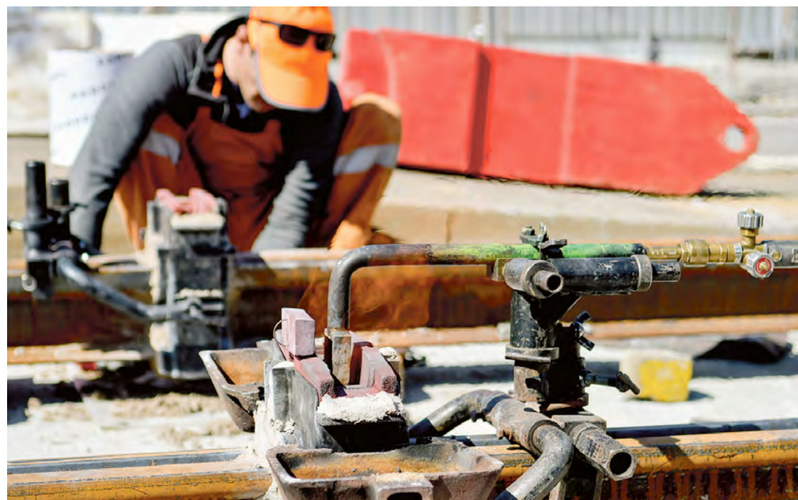
Spawanie torów podczas remontu torowiska na pl. Jana Pawła II, który miał miejsce w 2022 roku
