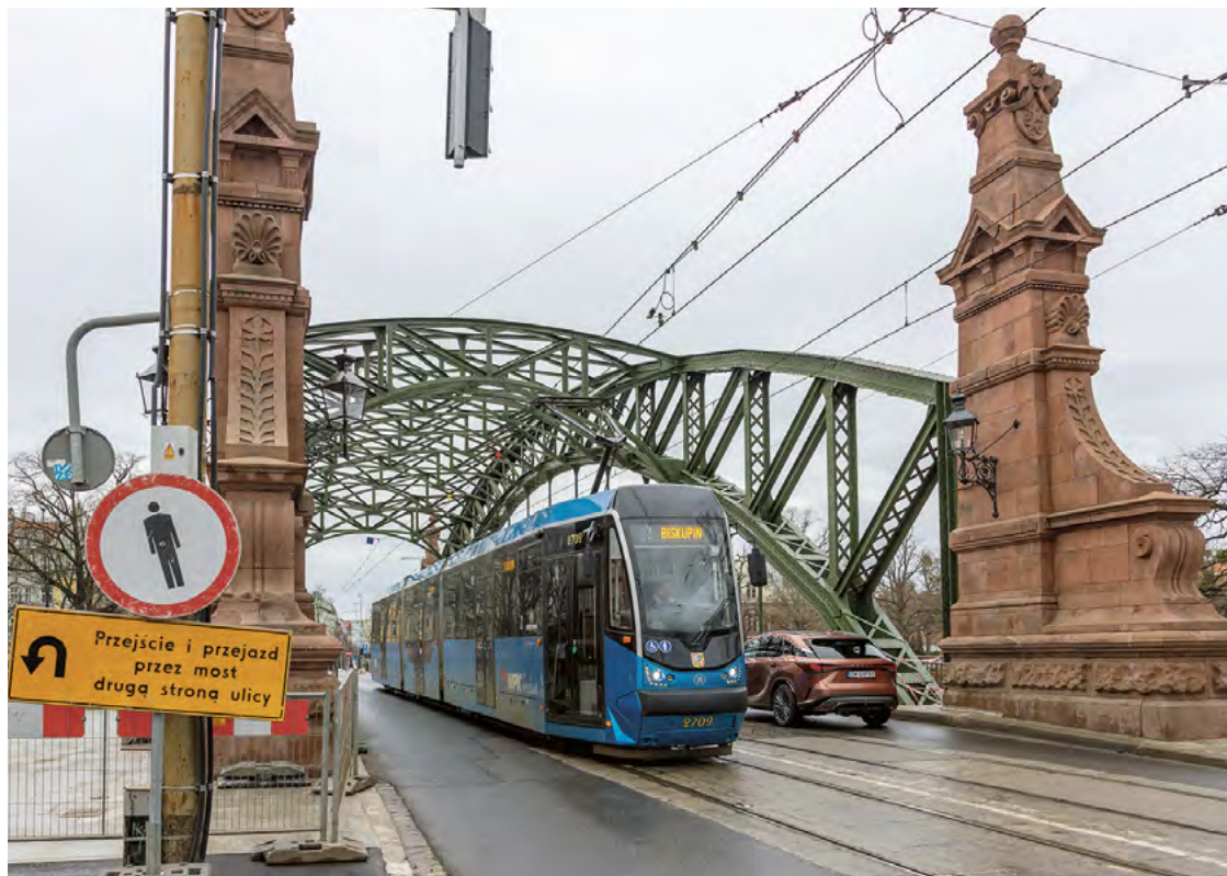
Wykonawca potrzebuje jeszcze kilku tygodni z dobrymi warunkami atmosferycznymi, by dokończyć remont
